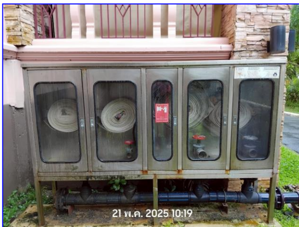
รูปที่ 2.59 สายฉีดน้ำดับเพลิง ขนาด 1 นิ้ว ยาว 30 เมตร จำนวน 2 เส้น
