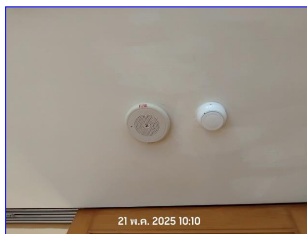
รูปที่ 2.35 เครื่องตรวจจับควัน
