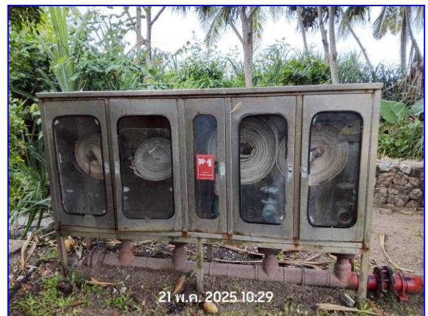
รูปที่ 2.59 สายฉีดน้ำดับเพลิง ขนาด 1 นิ้ว ยาว 30 เมตร จำนวน 2 เส้น
