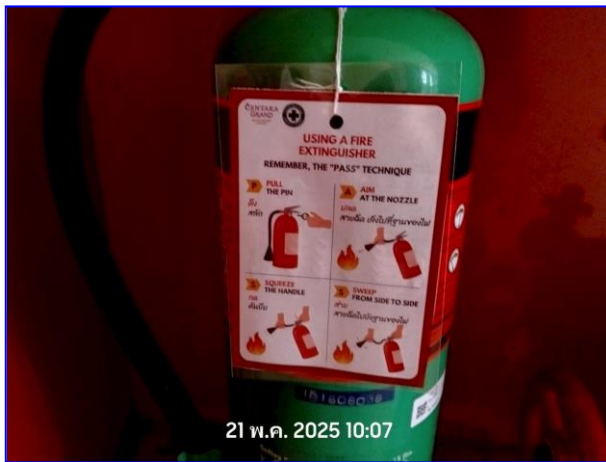
รูปที่ 2.39 ถังดับเพลิงและป้ายแนะนำวิธีการใช้ถังดับเพลิง
